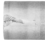
Risse an den Rollen
